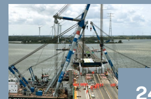
Haringvlietbrug: Gerenoveerd in recordtijd
